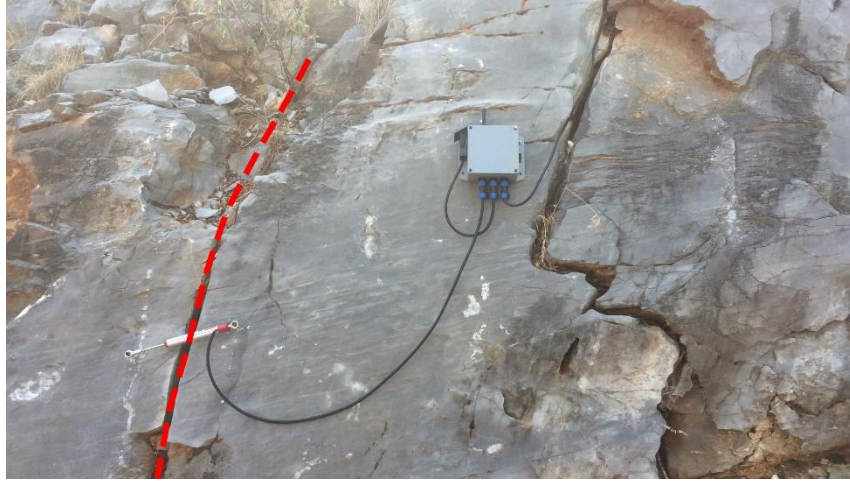
Şekil 3: Sahada uygulanmış sensör örneği
